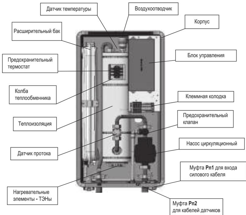
**Рисунок 1 -** Внутренние элементы электрического котла.
